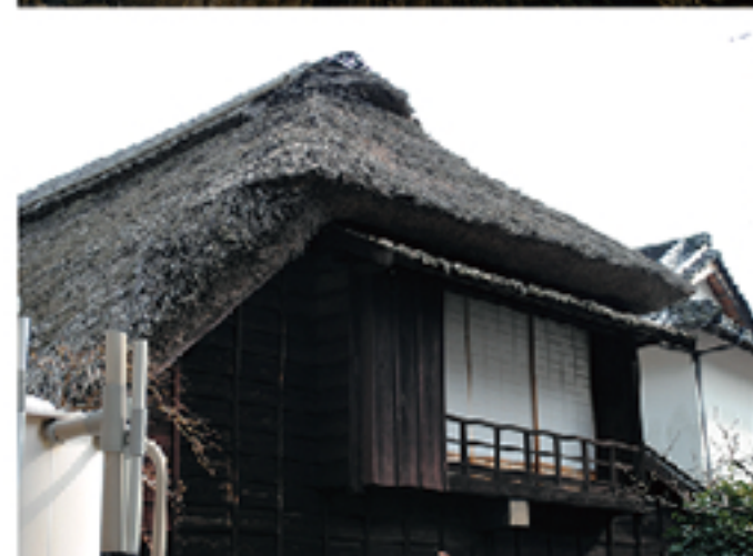
左上写真: 小屋裏の屋根組(工事時) 左下写真: 改修工事前の寓寄処 右写真: 改修工事を終えた茅葺屋根。
